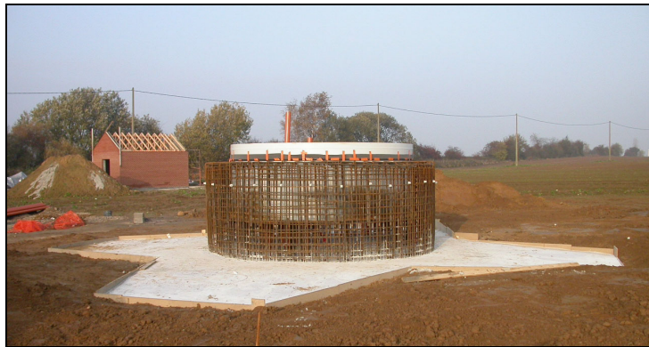
Figure 2: Armature de la fondation d'une éolienne du parc de Perwez (source : AIR ENERGY).
