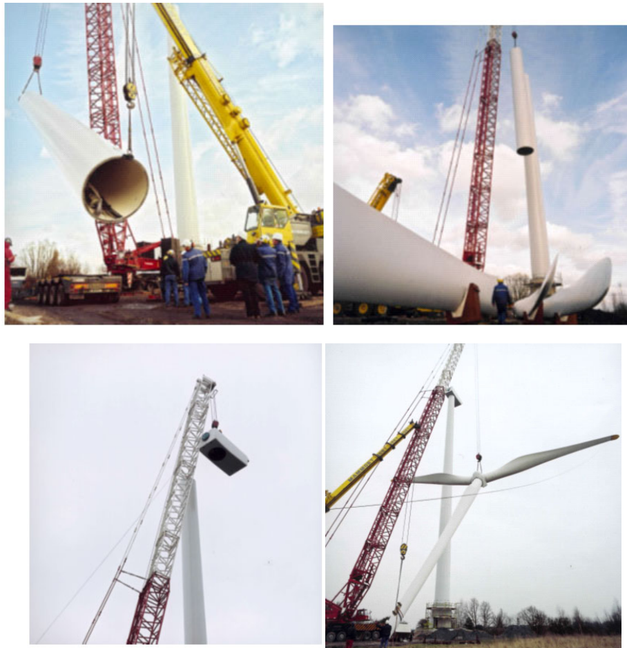
Illustration 2 : Montage d'une éolienne du parc de Schelle (source : Electrabel).
