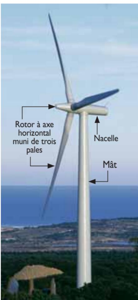
Elle est constituée d'un **mât** de 50 à 110 m de haut. À son sommet se trouve une **nacelle** équipée d'un **rotor à axe horizontal**, à trois **pales** mises en rotation par le vent. Le diamètre du cercle qu'elles balayent varie de 40 à 120 m.
