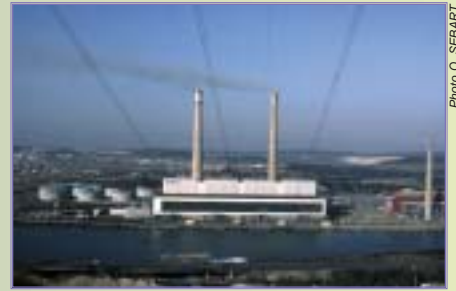
Centrale thermique EDF de Porcheville (78)
