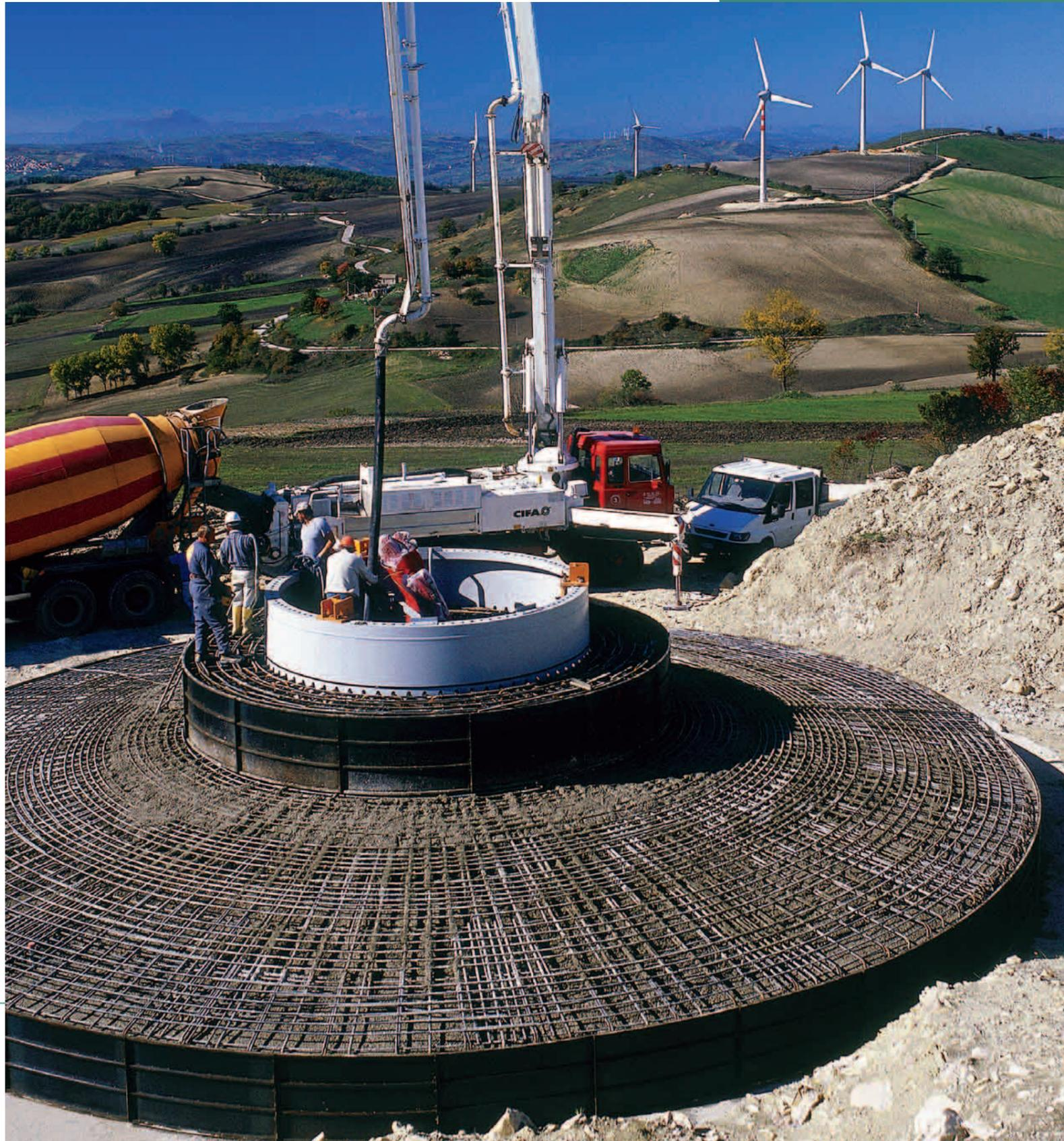
*L'armature acier dans la fondation circulaire ENERCON avec la section de fondation pour mâts acier de grande hauteur*
